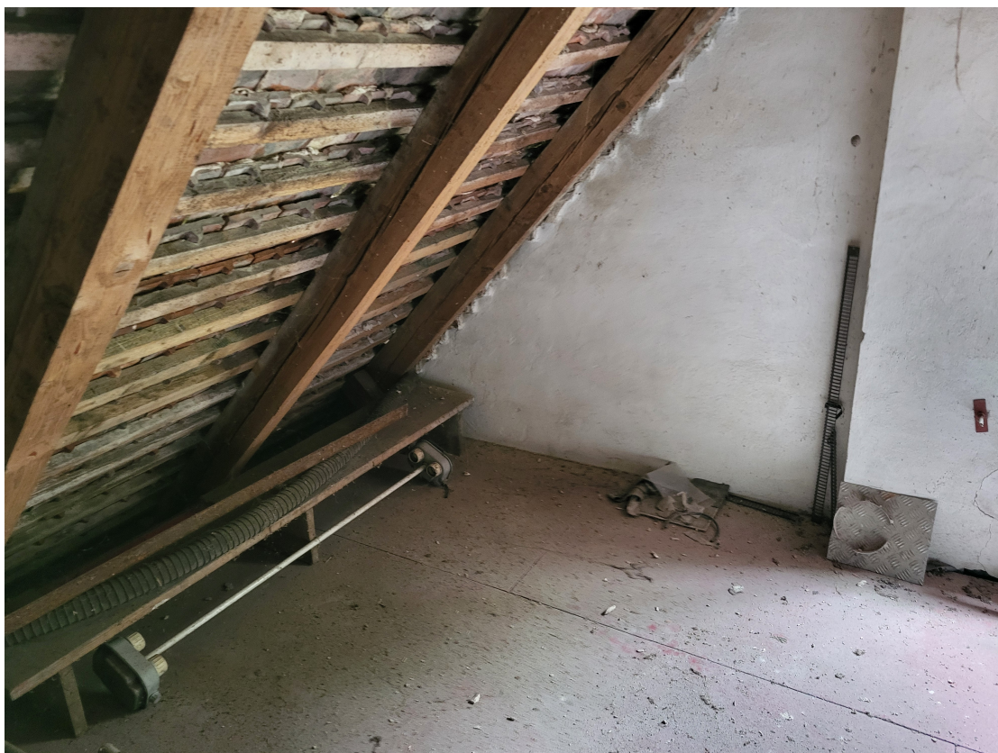
Widok nieizolowanego skosu dachowego na poddaszu – fot. 7
