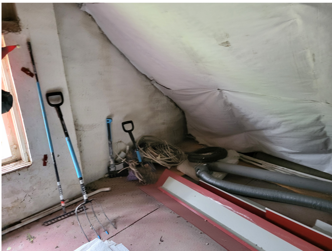
Częściowo wykonane prace izolacyjne skosu dachowego – fot. 8
